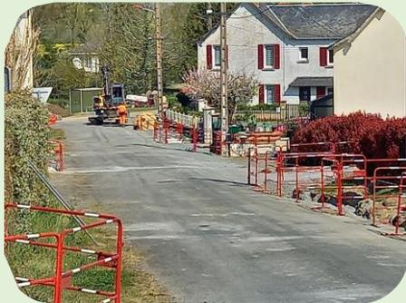
Des **travaux d'effacement des réseaux** sont réalisés **dans le secteur "Au Dela l'Eau"**, visant à gommer du paysage les câbles électriques et téléphoniques en les enterrant dans le sol, auxquels se sont ajoutés des travaux d'éclairage public.
