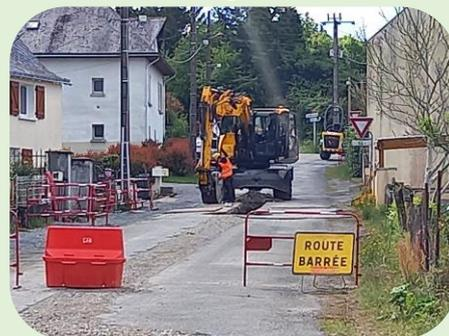
Devant l'état de vétusté du réseau d'eaux pluviales, il a été décidé de le remettre à neuf avec la pose d'une nouvelle canalisation incluant des regards récepteurs d'eau en milieu de chaussée dans l'éventualité d'un réaménagement de celle-ci, les eaux pluviales seront évacuées plus directement dans l'étang.
