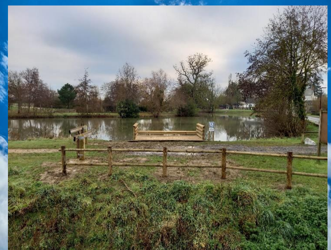
Installation d'un ponton à l'étang d'Au Dela l'Eau
